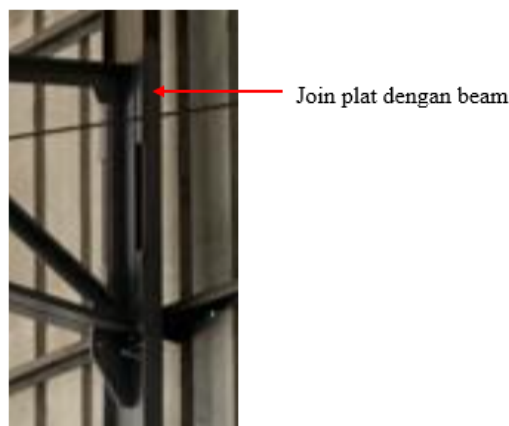
Gambar 3. Joint Plat Adaptor dengan Beam
