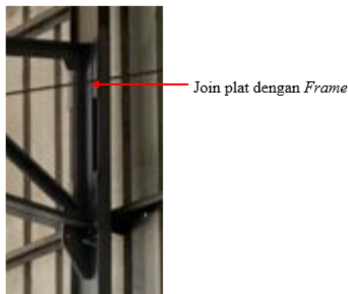
Gambar 4. Joint Plat Adaptor dengan Frame Lifeline
