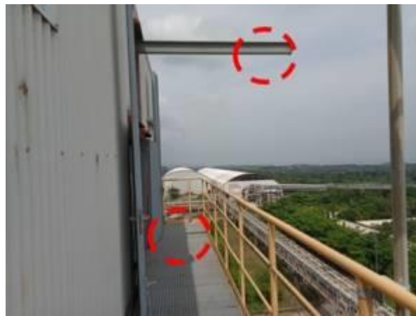
Gambar 1 Tidak Tersedianya Lifting tool
