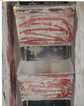
Gambar 11. Pengecekan Kondisi Bucket
