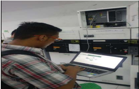
Gambar 1 Menghubungkan Laptop dengan Perangkat ACO
