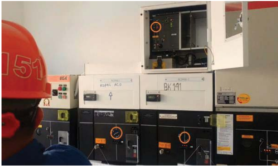
Gambar 11 Koreksi status pada perangkat ACO dengan kubikel terpasang
